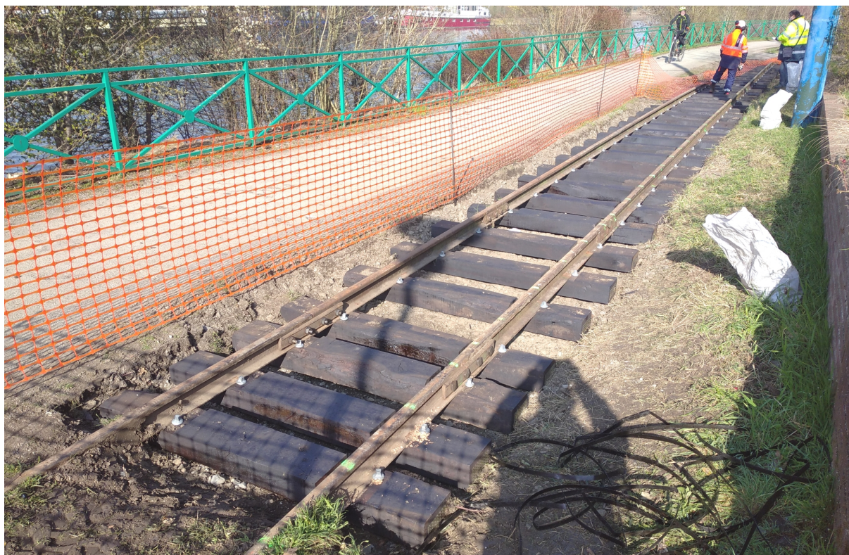
Renouvellement de traverses à Wambrechies en mars 2021
