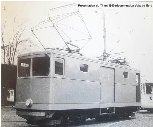
Mi 1950, suite au transfert sur la ligne R du réseau urbain de la première série 401 à 415 (la motrice n° 435 reprend le numéro 415), la motrice n° 415 d'origine est transformée en Tracteurs de Secours (déplacement des montants latéraux vers les extrémités, pose d'un tôleage latéral avec portes coulissantes, suppression des deux plates-formes et du lanterneau de toiture et avec des aménagements intérieurs spécifiques) ; et par l'installation de deux pantographes SIEMENS (type SNCV).
